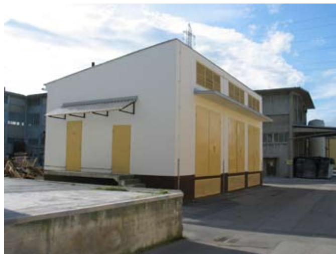
... in po obnovi
