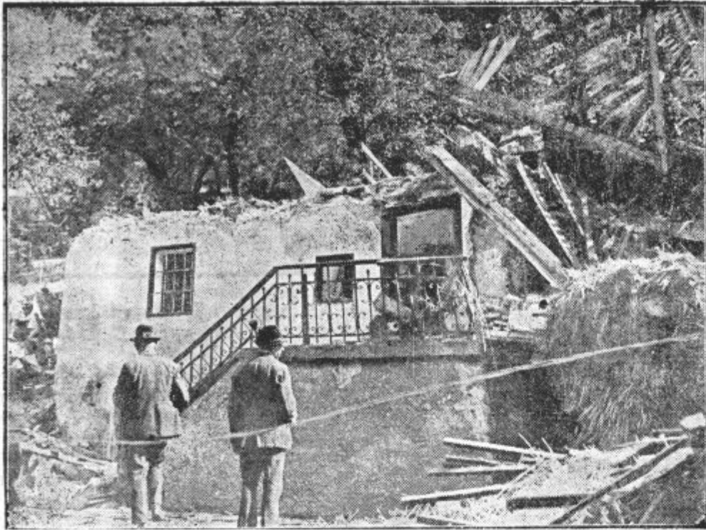
Porušena hiša Alojzija Novaka.
