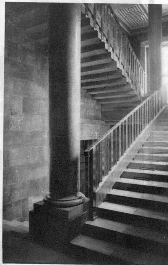
Pogled na del monumentalnega stopnišča Zbornice za TOI v Ljubljani, ki ga je po Plečnikovi zamisli izdelal njegov učenec, arh. Tomazič.
