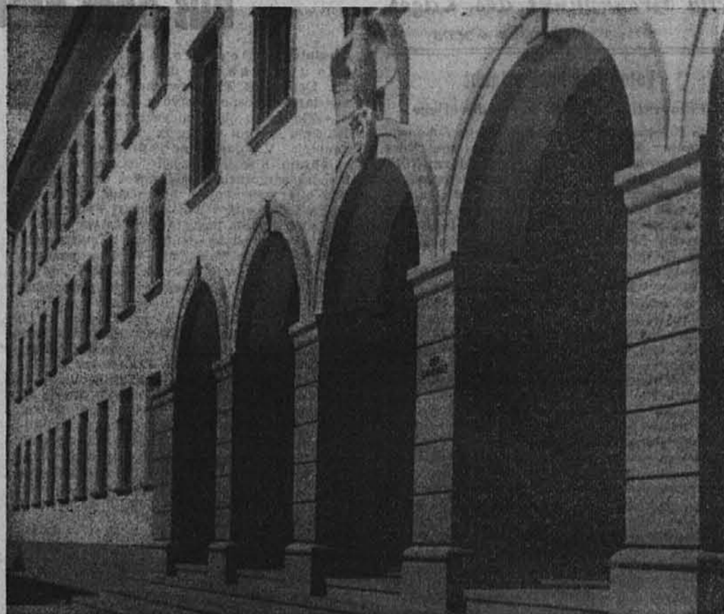
Pročelje Landratsamta v Krainburgu.
