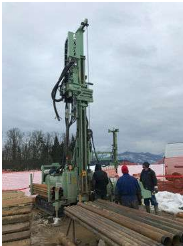
Slika 1. Vrtanje nove merilne postaje monitoringa podzemne vode v Podreči na Sorškem polju, februar 2018 Figure 1. New groundwater measuring station in Podreča on Sorško polje, February 2018
