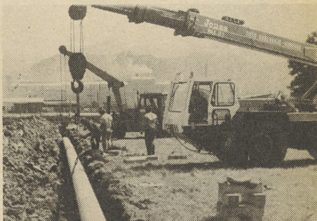
Samo še trenutek in tudi drugi del cevovoda bo v jarku
