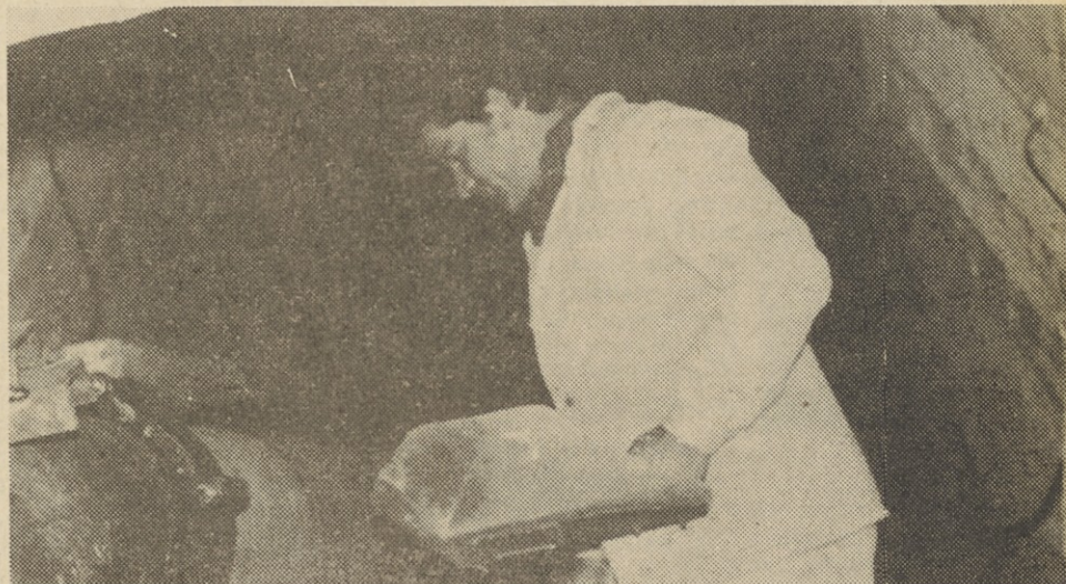
Elektrovarilec Alojz Kastelic pri varjenju v tunelu
