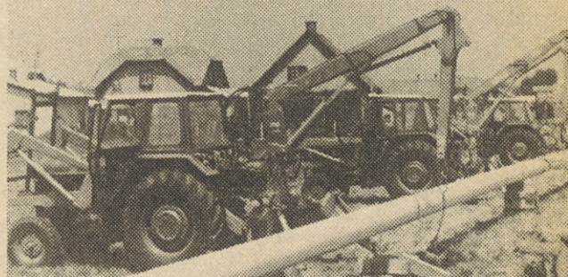
Za polaganje cevovoda uporabljajo v TOZD OV traktorje IMT
