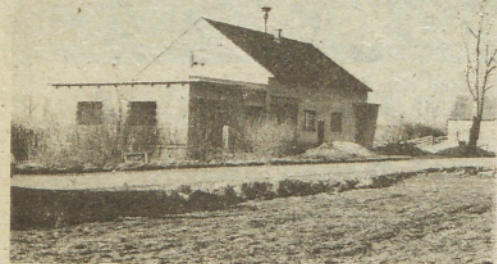
V Strukovcih bodo za dokončno ureditev vaškega gasilkega doma — prizidali so tudi primeren prostor za dvorano, v kratkem času spet prišli za delo. Vsako odlašanje precej slane. Foto: Š. Abraham
