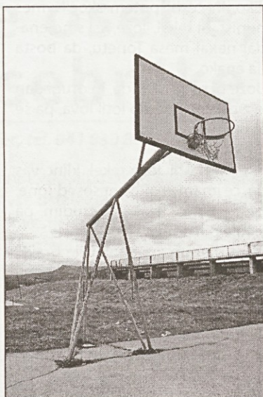
Igrišče pred obnovo
