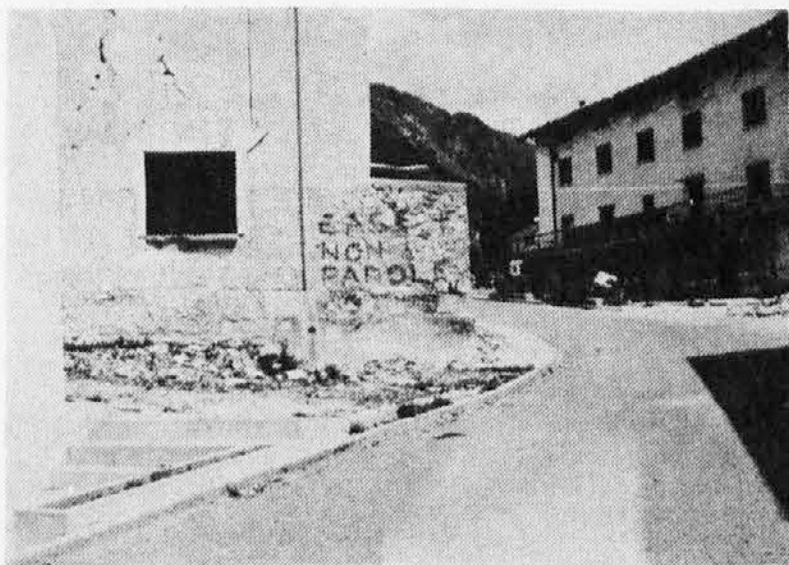
Rezijska je bila hudo poškodovana od zadnjega potresa. Birokracija zavlačuje delo obnove. «Hiše, ne besed» piše na nekem zidu
