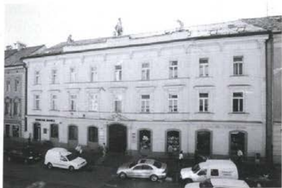
Obnovljeno pročelje sedeža Mohorjeve družbe v Celju
