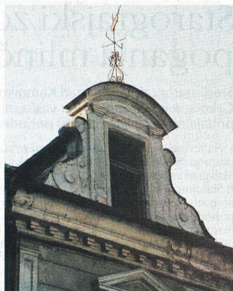
Arhitektonsko oblikovano strešno okno na objektu Glavni trg 11.
