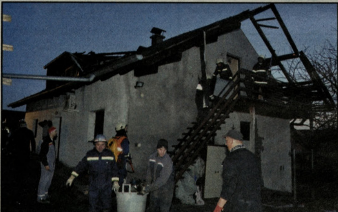
Po ugotovitvah o vzrokih požara so se lotili odstranjevanja posledic
