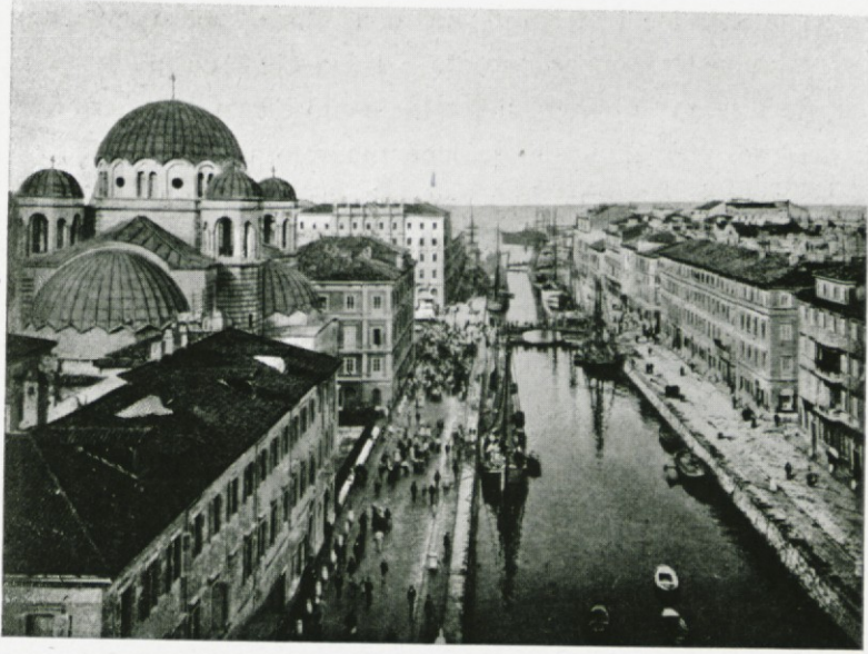
LO SBOCCO SUL CANALE.
