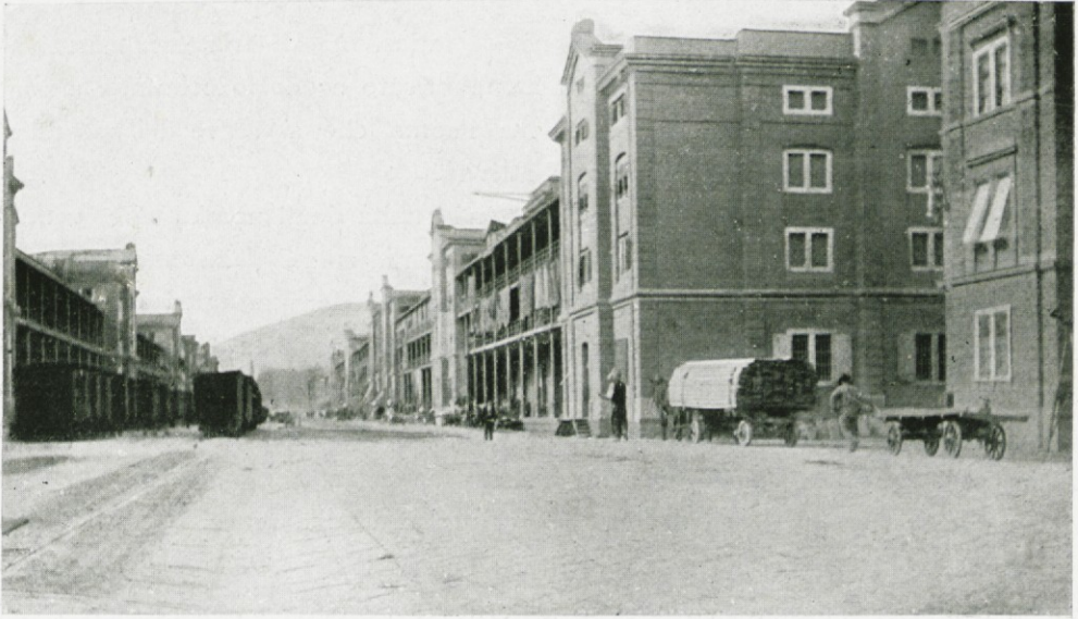
MAGAZZINI DEL PORTO NUOVO.
