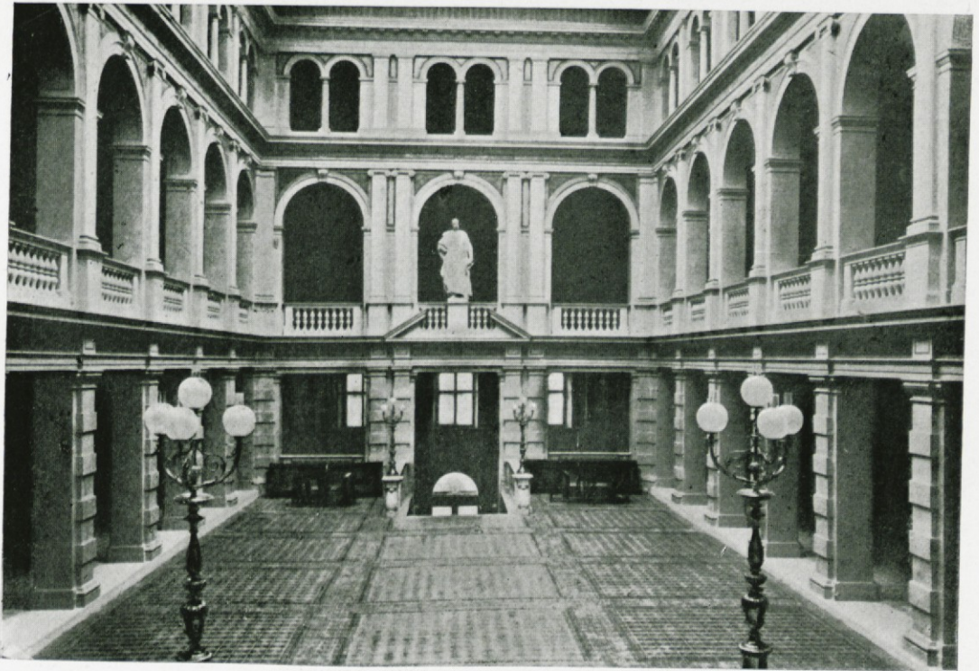
INTERNO DEL PALAZZO DELLE POSTE.
