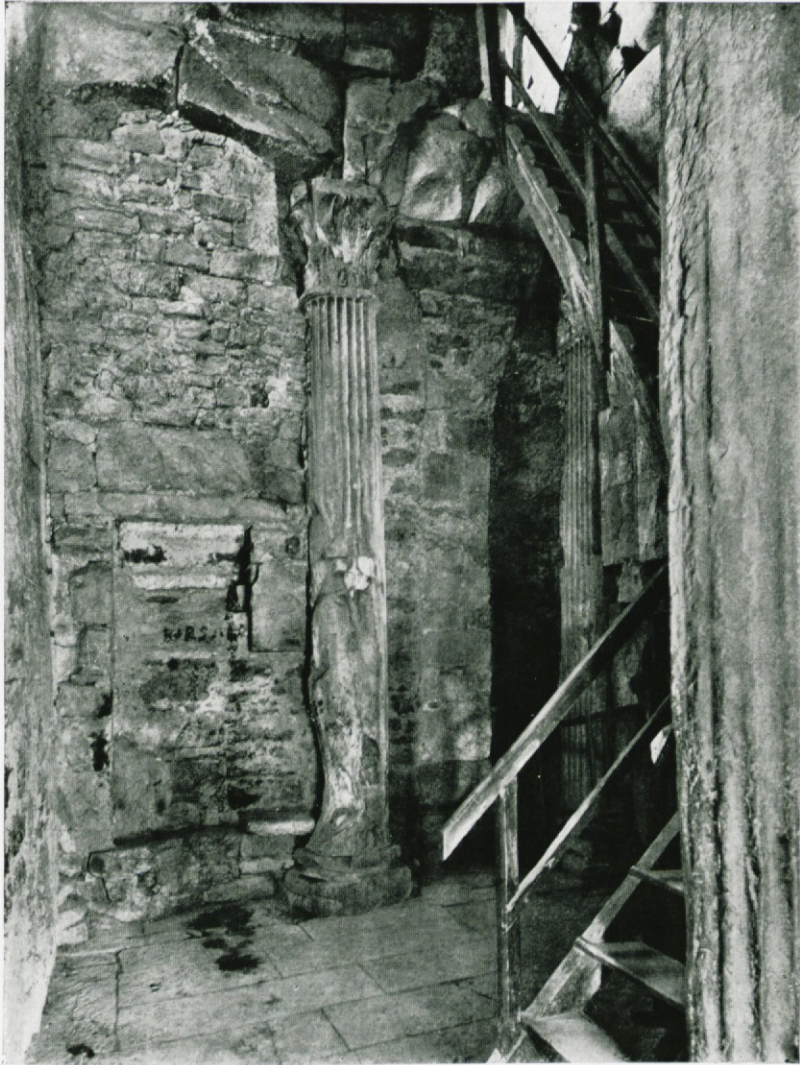
INTERNO DEL CAMPANILE CON LE COLONNE DEL TEMPIO ANTICO.
