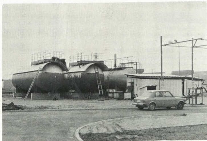
Rešitev skladišča za tekoči naftni plin
