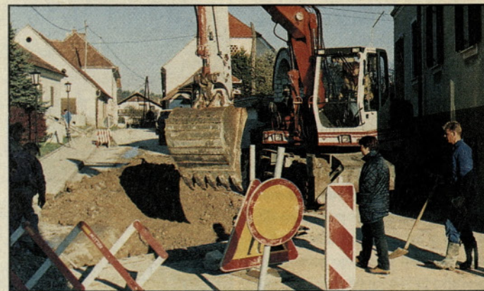
Izgradnja kanalizacijskega kanala iz trga Braslovče proti jezeru
