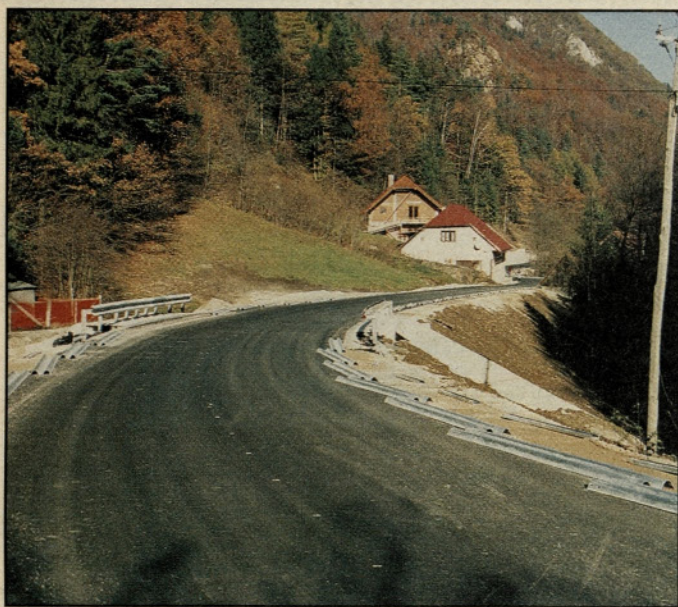
Cesta na predelu cestišča, kjer je bilo potrebno narediti most čez potok Reko.
