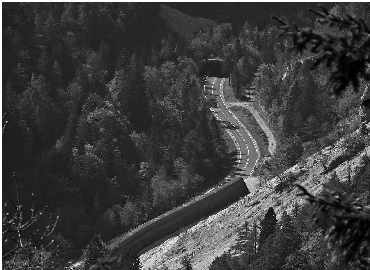
Slika 5: Snežna galerija na cesti proti Ljubelju še danes služi svojemu namenu. Slika prikazuje zgornji vhod v galerijo (na sliki zgoraj), ki je danes popolnoma poraščena. Zaradi skalnih odlomov, ki so aprila 2019 ogrozili cesto, 25 je danes pred zgornjim vhodom zgrajena več metrov visoka in več deset metrov dolga kamnita pregrada (na sliki spodaj), ki cesto varuje pred padajočimi skalami in snegom (foto: Matija Zorn).
