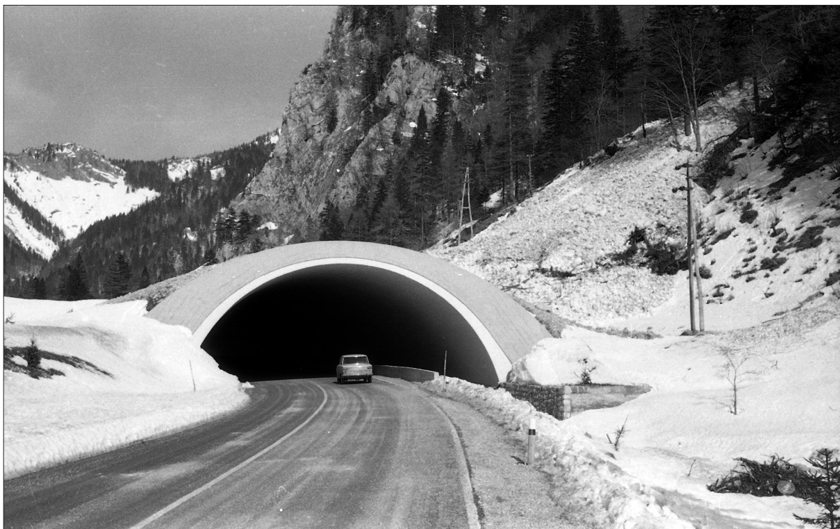
Slika 3: Snežna galerija na cesti proti Ljubelju, na odseku pod Begunjskim plazom, kmalu po zgraditvi (hrani: Jože Pintar).
