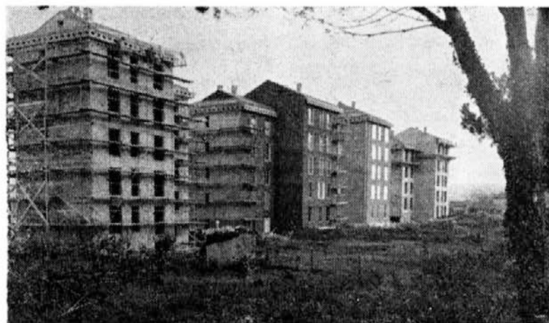
Pogled na nove stolpnice s Prešernove ceste
