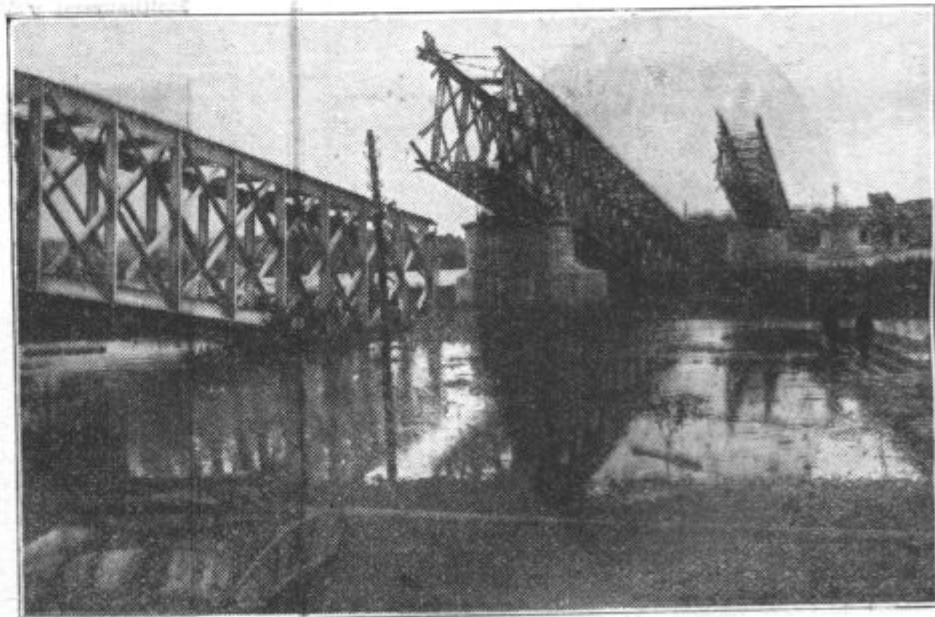
Železniški most med Beogradom in Zemunom, ki ga je takoj po vojni napovedi razstrelila avstrijska vojska. Po zavzetju Srbije pa ga je že po nekaj mesecih z veliko težavo na novo zgradila in je tudi marsikateri naš slovenski vojak pomagal pri gradbenih delih. Ob porazu v jeseni je pa bežeča avstrijska vojska drugič pognala v zrak zemunski most. Po dolgih letih je naša država predlanskim postavila na istem mestu nov in današnjemu prometu ustrežajoč most. Ko je bil dograjen, smo prinesli tudi v našem listu njegovo sliko
