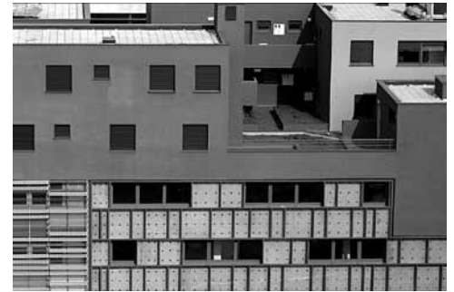
Stanovanjsko poslovni kompleks Zagrad, Reka, 2007, streha. Zagrad Centre, Rijeka, 2007, the roof.
