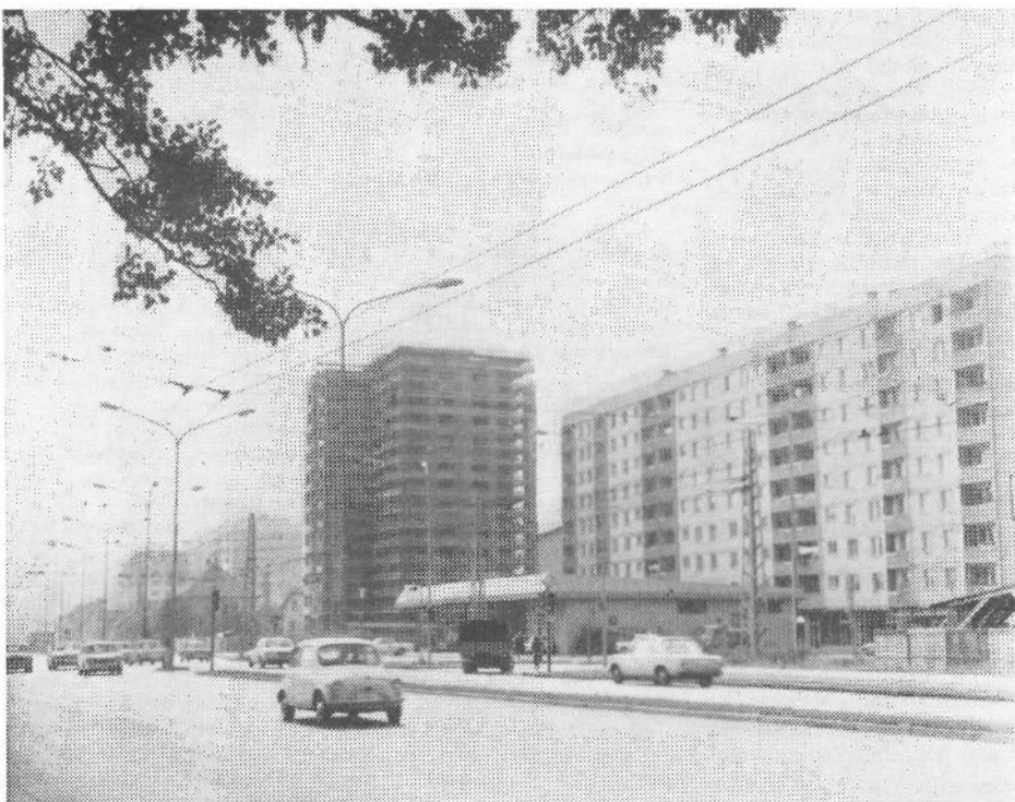
Novogradnje ob Celovski cesti
