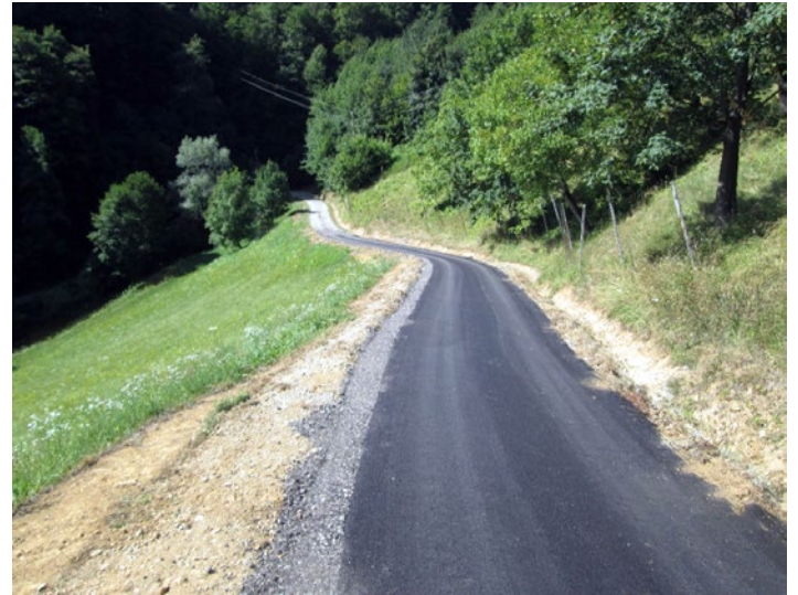
Asfaltiranje ceste zveličarjev breg, II. faza
