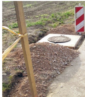
Izgradnja kanalizacije v Šturmovcih
