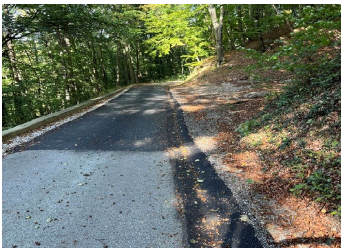
Sanacija poseda ob opornem zidu med Dravinjskim Vrhom 29 ter Varejo
