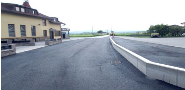
Posodobitev odseka ceste v Pobrežju
