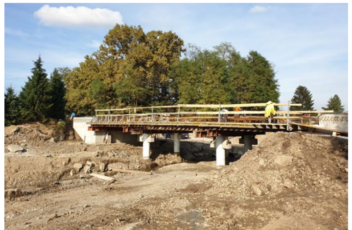
Novi most v Lancovi vasi tik pred začetkom izvedbe betoniranja. Foto: Matjaž Klasinc
