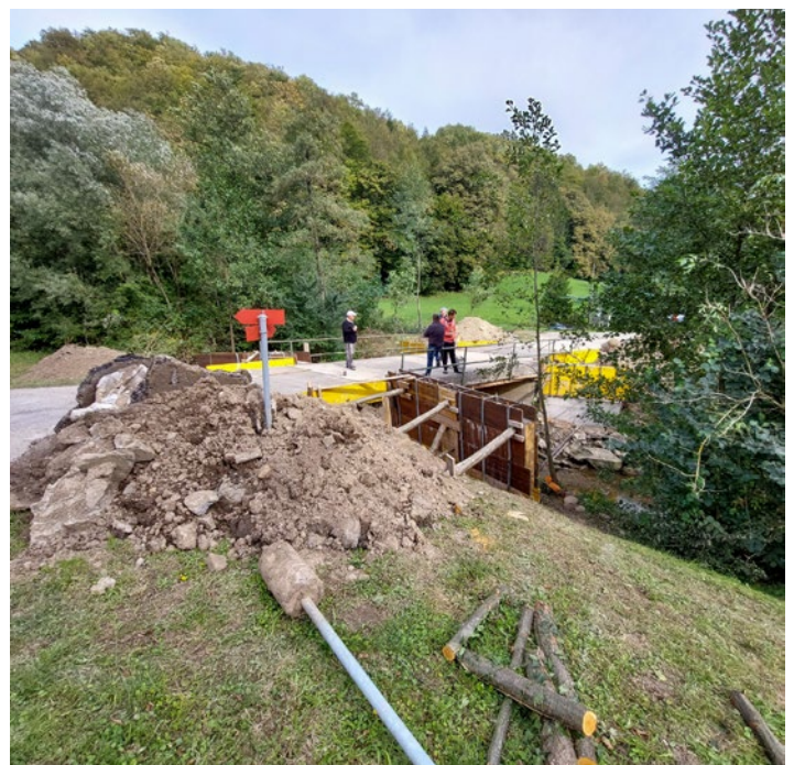
Sanacija »izpodjedlih« brežin potoka Peklača na odcepu v Staro grabo
