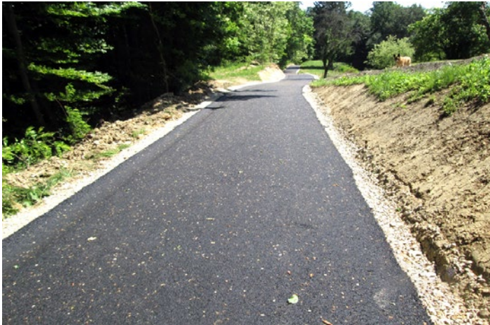
Posodobljena cesta v Ljubstavi
