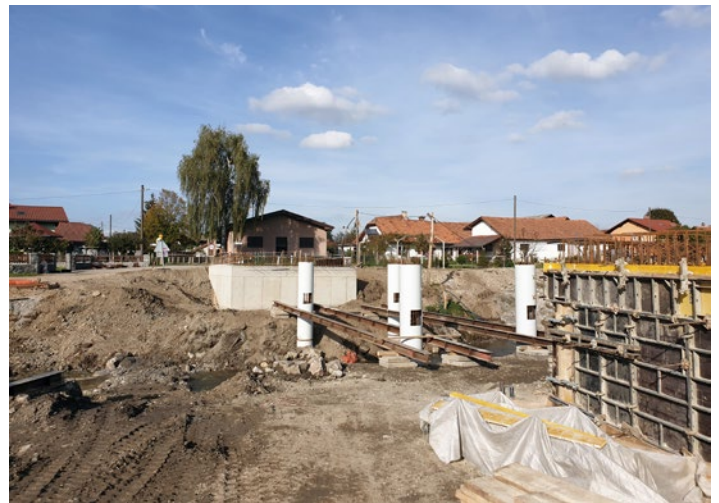
Novi most Sela v izgradnji. Foto: Matjaž Klasinc
