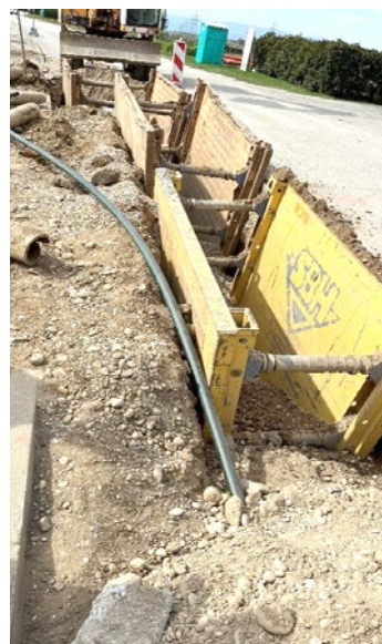
Izgradnja kanalizacije v Lancovi vasi
