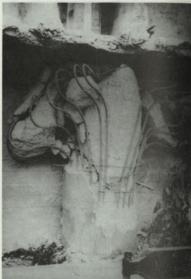
Slika 20. Porušitev mostnega stebra s šibkimi stremeni
