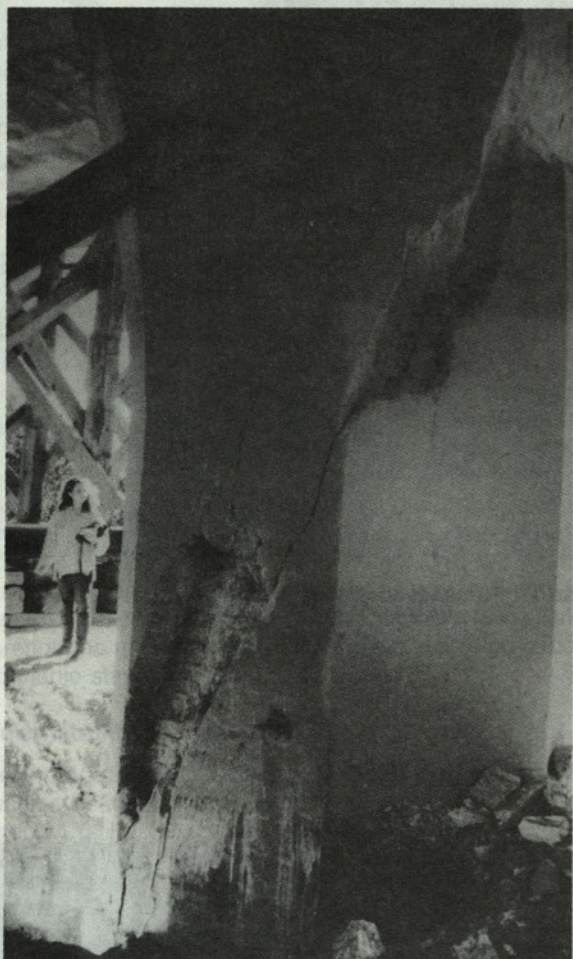
Slika 20. Porušitev mostnega stebra s šibkimi stremeni
