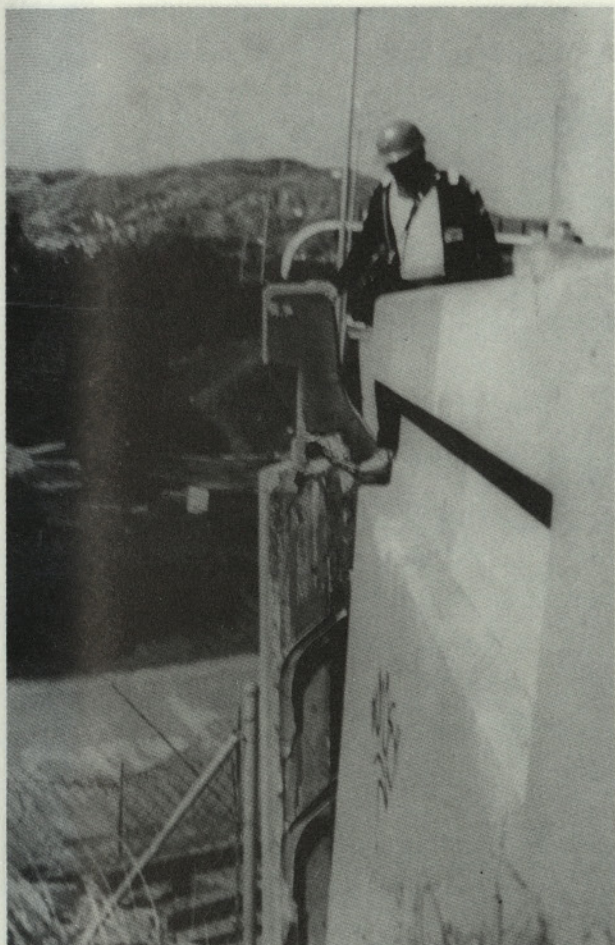
Slika 16. Zamik poševnega mosta na cesti 118
