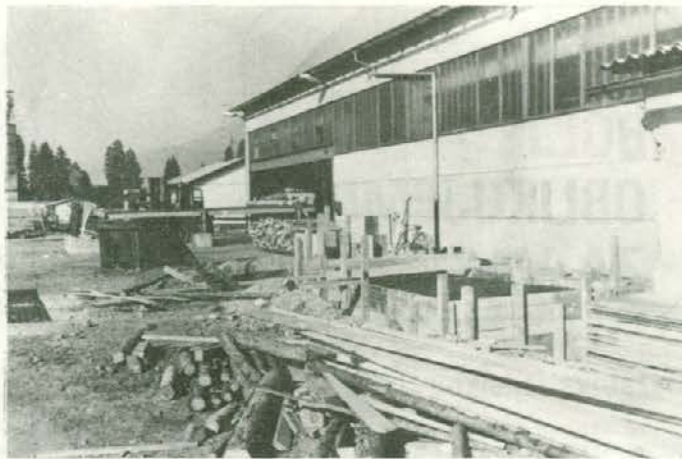
Temelji za objekt, kjer bo postavljen polnojarmanik
