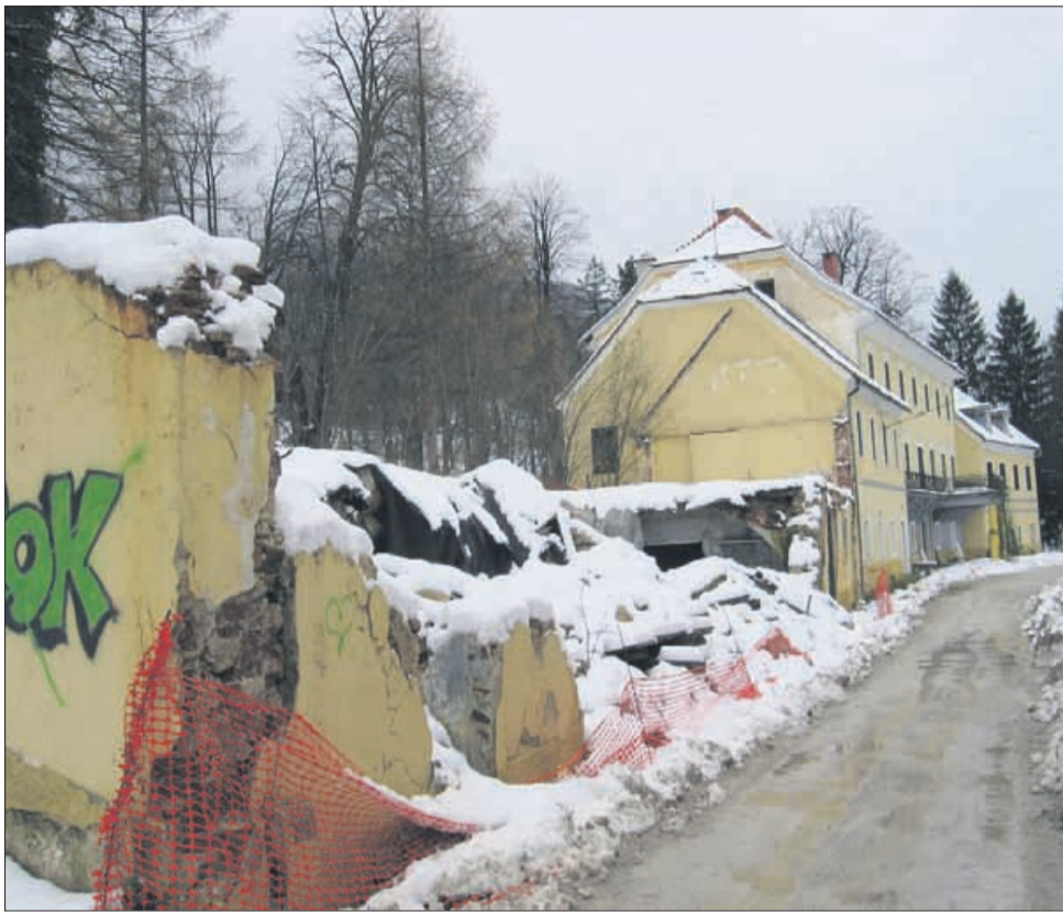
Občina, ki je prodala območje dvorca Trebnik, bo po desetletju in pol prejela nazaj podrtijo.
