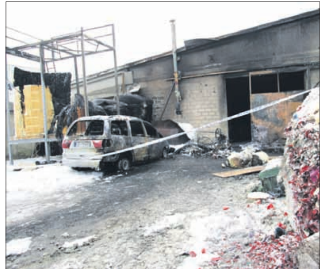
V požaru sta zagorela bližnja garaža in osebni avto, poškodovana so vrata v halo, zaradi vročine so popokala okna, v hali pa sta poškodovana dva stroja.
