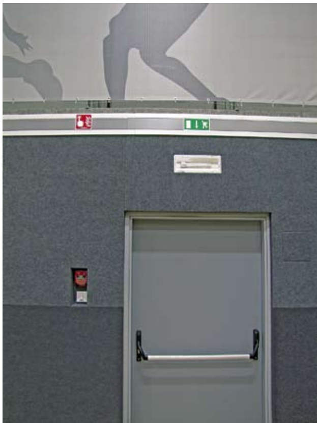
Slika 1: Prostor za oznake, umestitev javljalnika požara na steni in požarna vrata s protipanično kljuko v športni dvorani Krn na Fakulteti za šport v Ljubljani.
