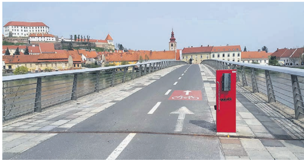
Jasno je, da si Ptuj v predpogajanjih z Direkcijo RS za infrastrukturo kot investitorjem sanacije dravskega mostu ni izpogajal veliko.
