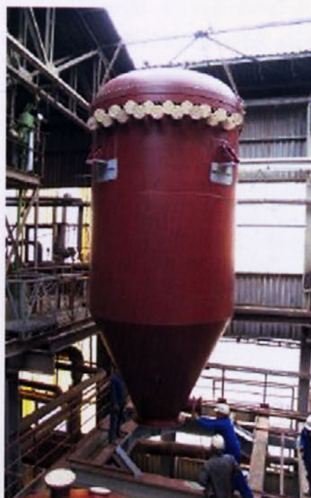
Nameščanje filtra v ležišče na etaži 15. metrov
