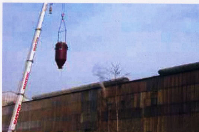
Spušcanje filtra skozi streho
