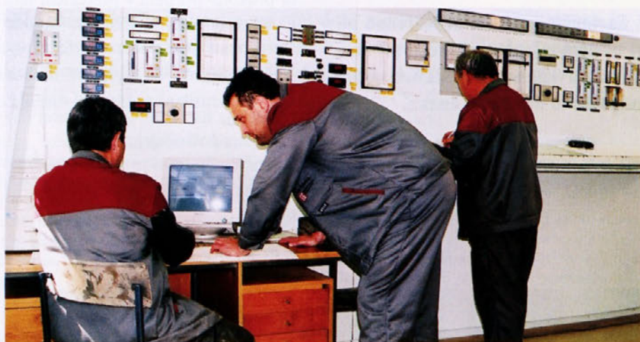
Zaposleni v PE Titanov dioksid so odeti v nova oblačila. V prvem delu proizvodnje nosijo kislinsko odporne bordo-sive, v končni predelavi pa sivo-bele delovne obleke. Vsaka obleka je opremljena z vidnim imenom in priimkom lastnika. Sledili jim bodo tudi v ostalih poslovnih enotah.
