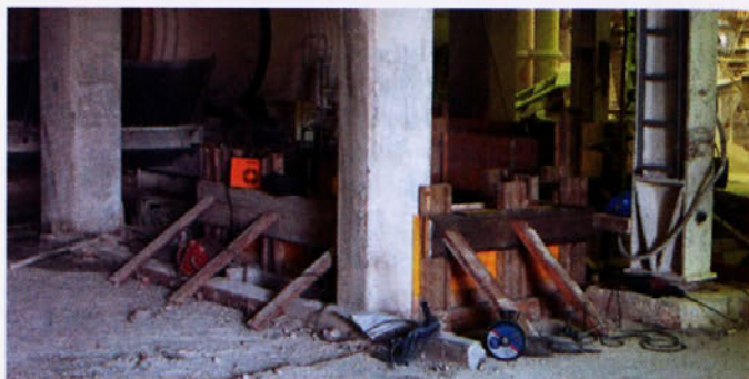
Priprava temeljev za nov hladilni stolp
