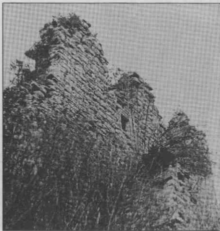
Sl. 18. Južna fasada Friderikove hiše z ostanki vhodnega stolpiča. Leta 1987
