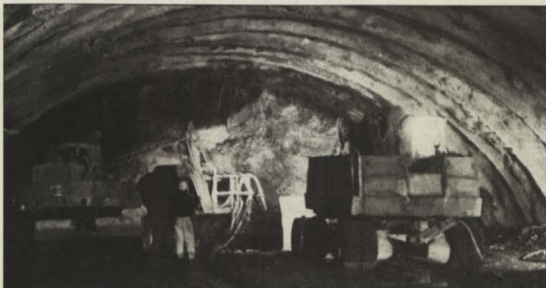
7.864 metrov dolg predor med Področico (Koroška) in Hrušico (Slovenija) so delavci kljub težkim geološkim razmeram zvrtili v 1021 dneh.
