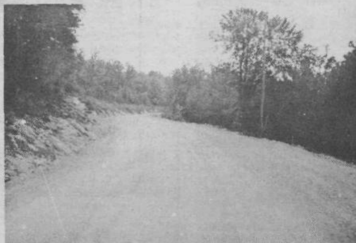
Pred položitvijo asfalta je nov odsek ceste Zagradec—Ambrus
