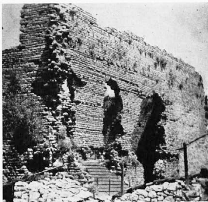
Sl. 27. Tehnika zidova palače na Mljetu
