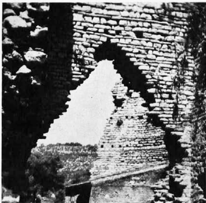
Sl. 28. Tehnika zidova palače na Mljetu
