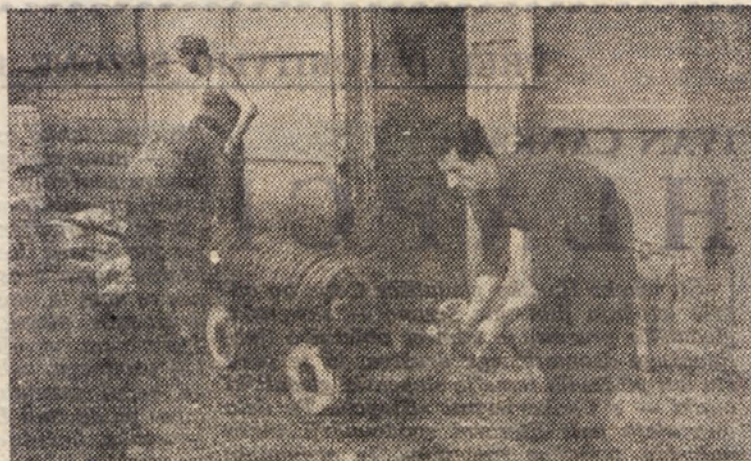
Vzdrževalci preizkušajo popravljeno grelno kačo.
