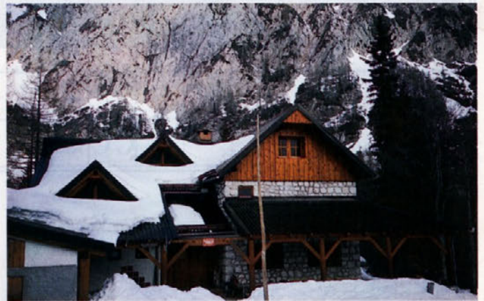
Prenovljeni dom na OKREŠLJU
