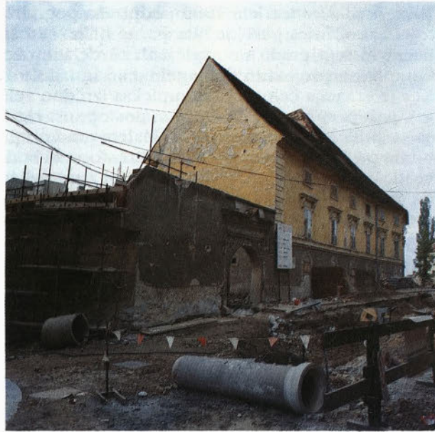
DELO SE JE ZAČELO... gradbišče malega gradu
