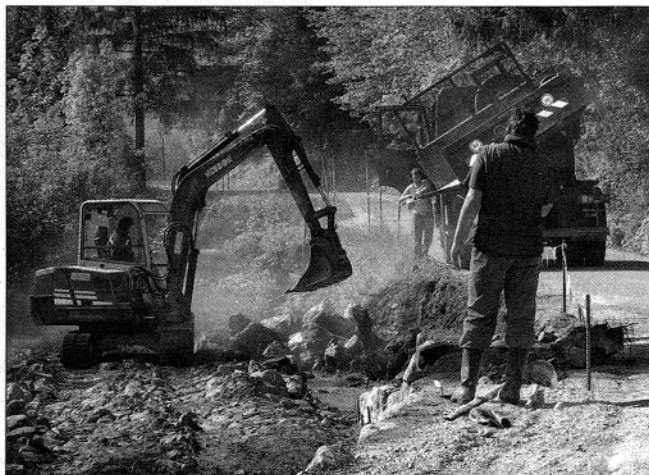
Okoli 150 metrov nove škarpe in ostala spremljajoča dela so ocenjena na 39.000 evrov (foto: Marija Lebar)
