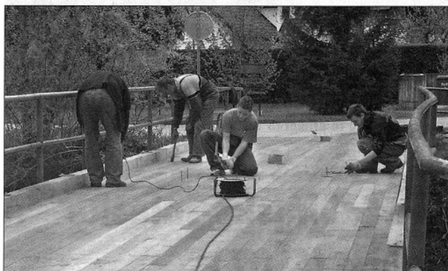
Delavci mozirske Komunale so na mostu odstranili zgornjo leseno plast in jo zamenjali z novo
