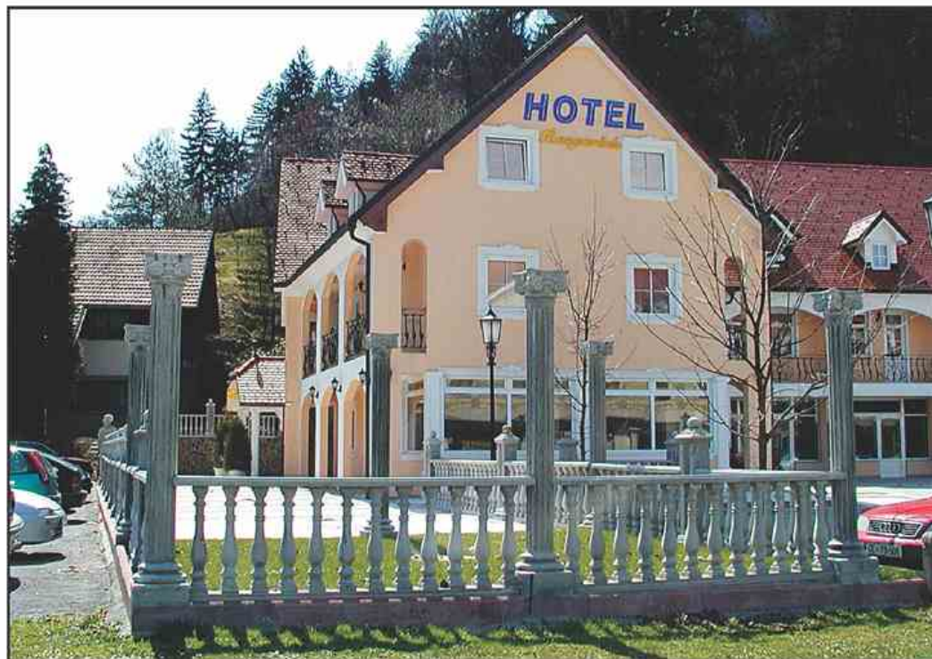
Nadstrešek nad vhodom v hotel Razgoršek in del letnega vrta sta postavljena na tujem zemljišču, zato hotel še vedno nima uporabnega dovoljenja. (foto: vos)
