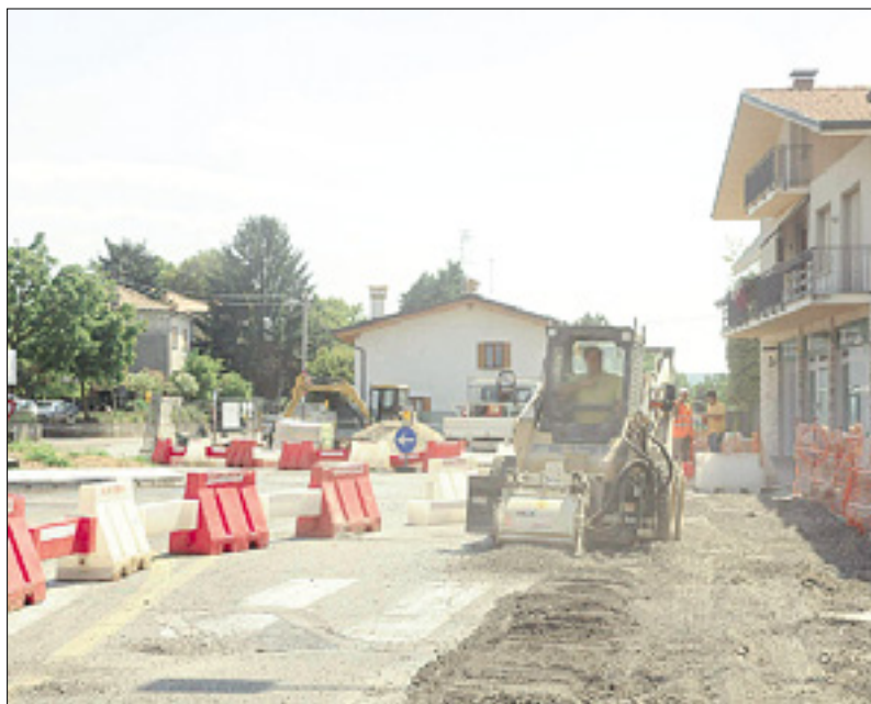
Gradbišče novega štandreškega krožišča je včeraj oživel
