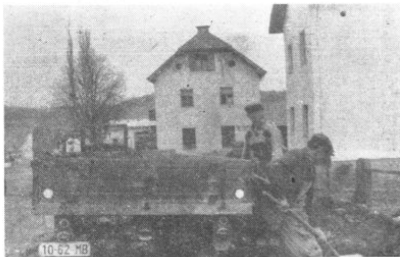
Pred dnevi so delavci začeli z utrjevanjem cestišča ob podjetju Klemos v Lenartu. To je hkrati začetek del na cesti skozi Lenart. Na sliki: delavci nakladajo zemljo
