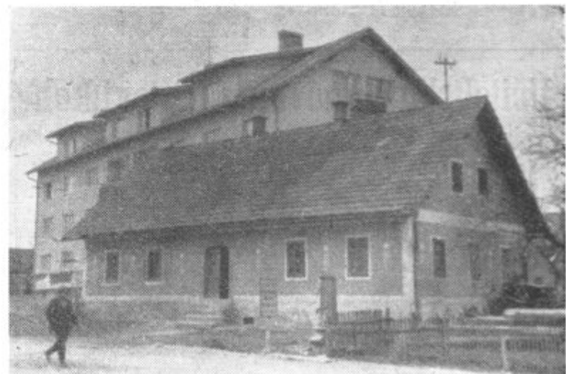
Tudi stanovanjska hiša na sliki bo kmalu odstranjena. Tako bo lep pogled na Lenart z radgonske strani. Zlasti bo dobro viden novi stanovanjski blok
