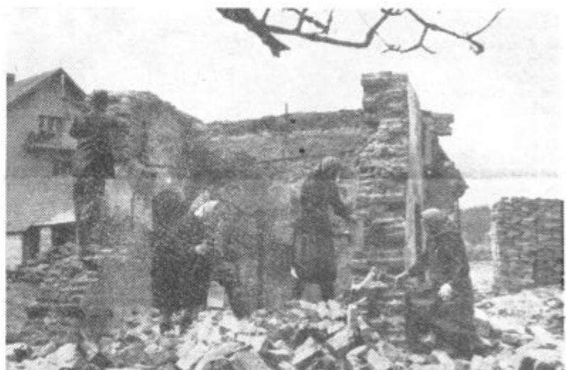
V Lenartu te dni na veliko podirajo nekatere zgradbe, ki jih bodo nadomestile druge ali pa bo novi prostor uporabljen za kaj drugega. Pravkar podirajo zgradbo, kjer je postaja LM. Pred kratkim pa so delavci podrli gospodarsko poslopje ob novem bloku. (Na sliki.)
