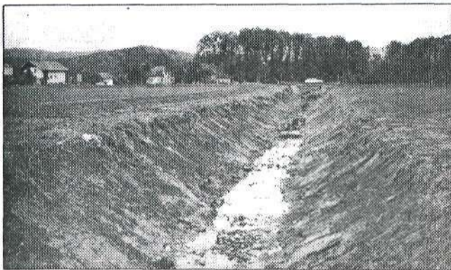
Del razbremenilnika na Pšati med cestama Moste-Komenda in Moste-Brnik so delavci vodnogospodarskega podjetja očistili grmovja in naplavin. Sedaj so stroje odpeljali. Menda na ostali del struge proti Žejam in Suhadolam niso pozabili?
