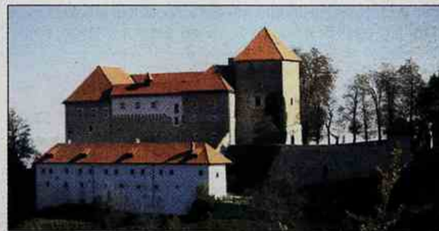
Po 25 letih obnove romanskega gradu Podstreda je na vrsti zaključek obnove spodnjega gospodarskega poslopja (na fotografiji sprednja stavba).
