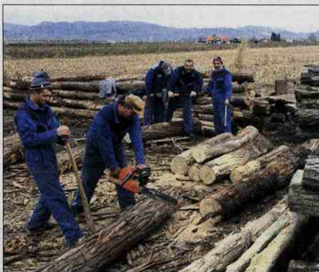
Zahtevna priprava lesenih drogov za postavitve
