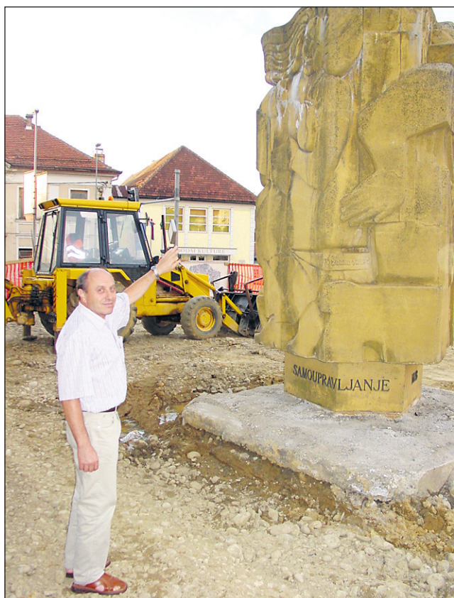
Podžupan Karl Vogrinčič: »Vodni kamen in alge je treba odstraniti in spomenik zaščititi z ustreznimi premazi.«
