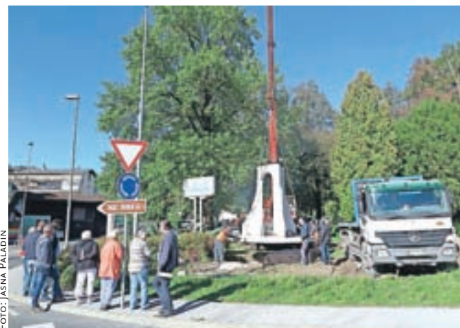
Kapelico so začeli postavljati v petek, 28. septembra.
