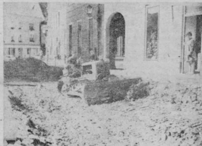
Boldožer rije in pripravlja podlago za novo tlakovano cestišče
