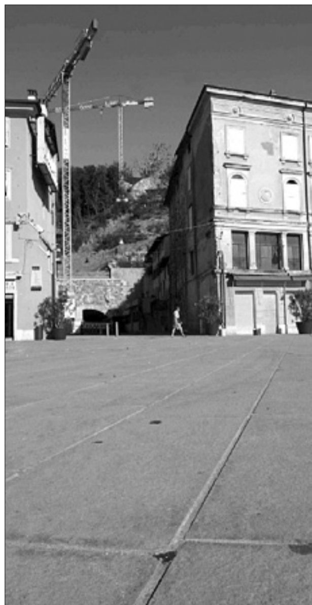
Pogled s Travnika na gradbišče na grajskem griču, kjer so dela prekinjena že več kot en mesec
