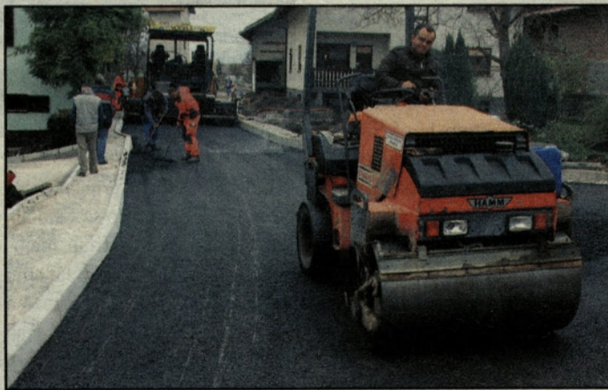
Pri asfaltiranju odseka ceste v Ločici ob Savinji
