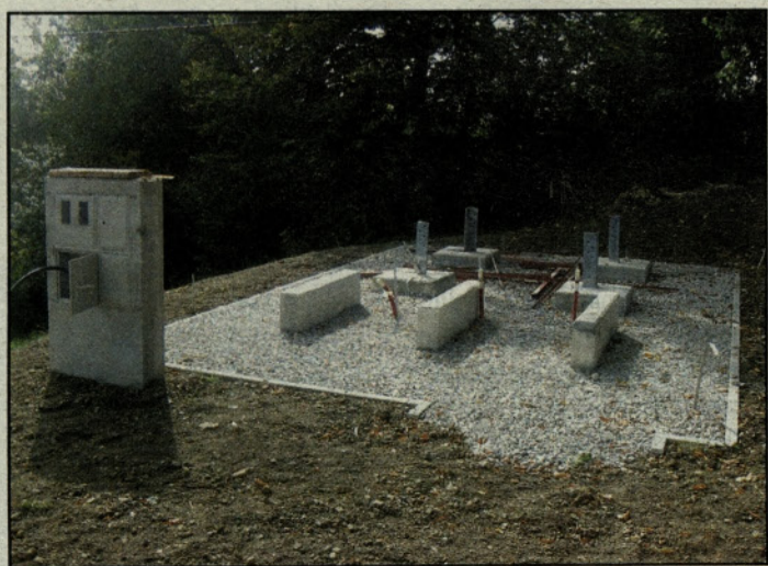
V Jeronimu je bazna postaja pripravljena za montažo stolpa
