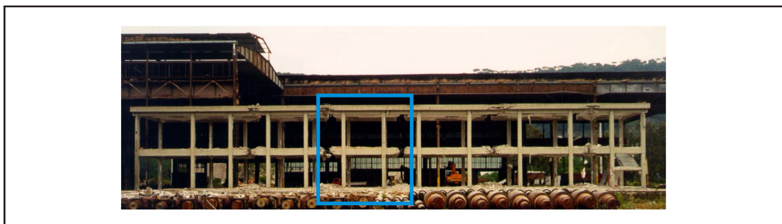
Slika 6.5: Fotografija celotne konstrukcija z označenim analiziranim delom. Figure 6.5: Photography of the entire structure. The analysed section is framed.
