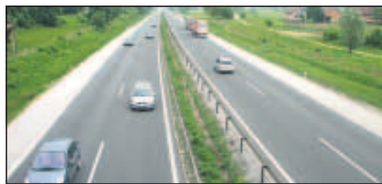
Za leto 2010 načrtovane izgradnje protihrupne zaščite na avtocestnem odseku Brezovica-Vrhnik ne bo.
