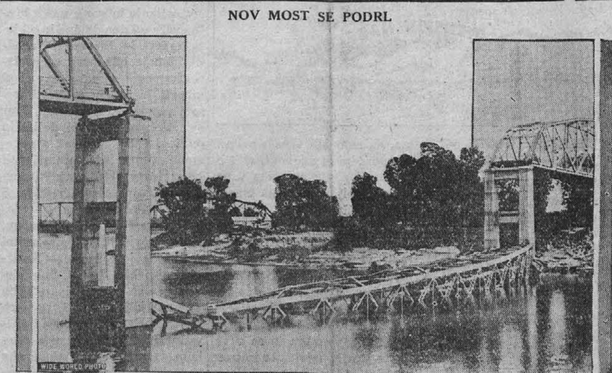
NOV MOST SE PODRL Komaj je bil zgrajen nov most, iz cementa in jekla, preko Rdeče reke pri Garland City, Ark., ki je stal pol milijona dolarjev, ga je tudi že čakal žalosten konec. Na štiri konce mostu je bila namreč podtaknjena velika množina dinamita; vsi štirje naboji so istočasno eksplozirali in vrgli v 35 čevljev globoko vodo kos mostu, dolg 300 čevljev. Storilcev niso dobili.
