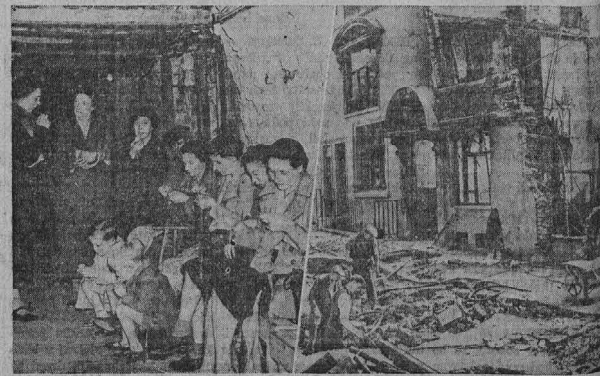
Na levi vidimo prizor v zaklonišču, 60 čevljev pod zemljo, kjer ženske pletejo oblečila vojake. Na sliki na desni pa delavci popravljajo vodovodne cevi, ki so jih razbile bombe.
